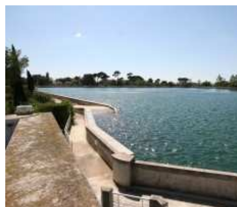
© Société des Eaux de Marseille - Direcção de Comunicação do 6ème Forum Mondial de l'Eau
